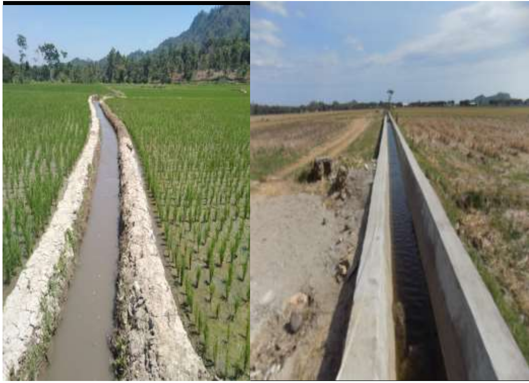
Gambar 3.3. Rehabilitasi Jaringan Irigasi D.I Bunga - Bunga Kecamatan Matakali
