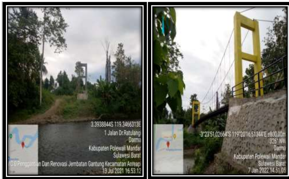
Gambar 3.2. Dokumentasi Kegiatan Rehabilitasi Jembatan Gantung Kecamatan Anreapi
