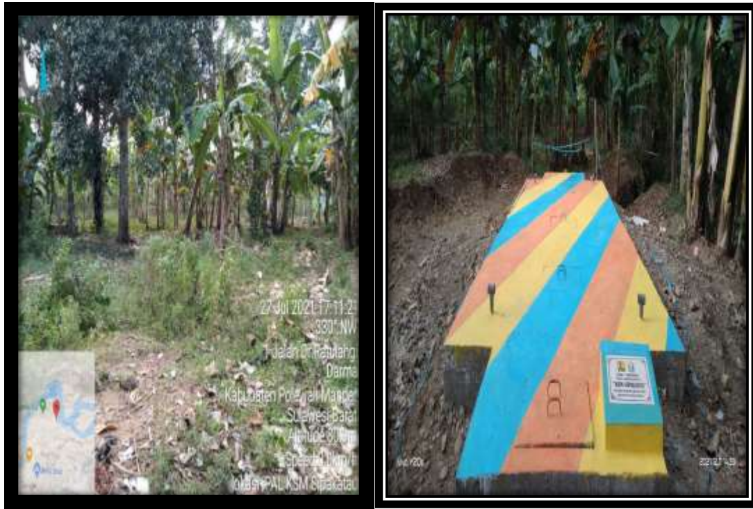
Gambar 3.7 Dokumentasi Kegiatan Pembangunan Sarana dan Prasarana Sanitasi Kel. Darma, Kec. Polewali
