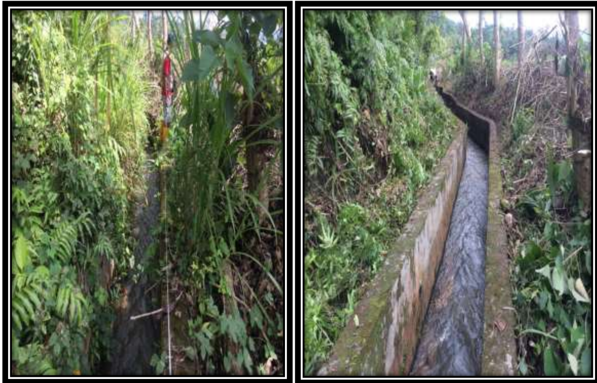
Gambar 3.4 Rehabilitasi Jaringan Irigasi Alapahang kecamatan Tapango
